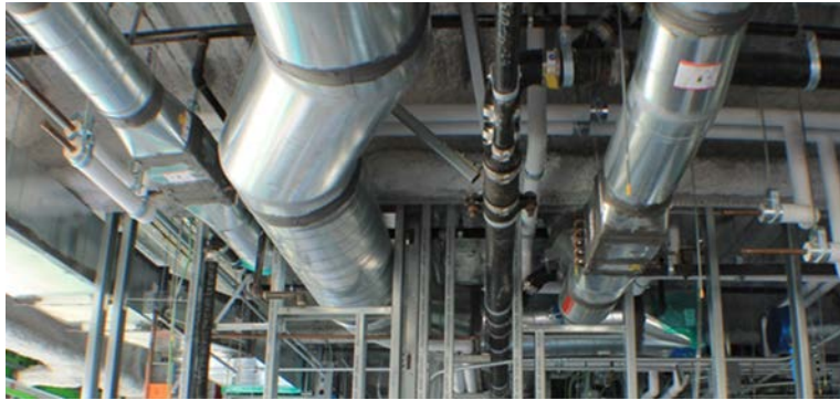
Actual drywall framing around the MEP equipment.
